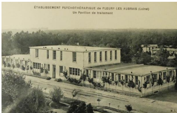
Figure 2 - Un pavillon de traitement
