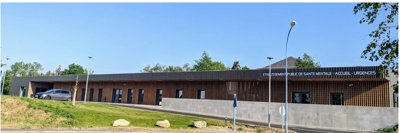
Figures 5 – Établissement Public de Santé Mentale : Accueil - Urgences
