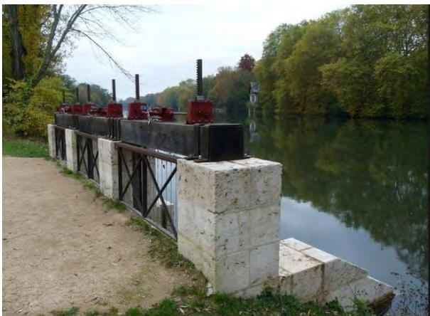
**Figure 13 : Seuil à vannes mobiles barrant le Loiret, à l'aval du bassin St Samson.**
