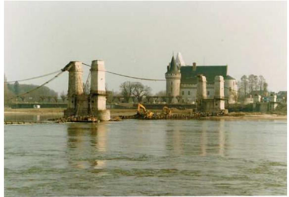
*Photo n° 21 : Dégagement du tablier avec accès RG.*
