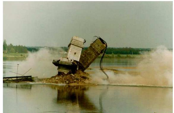
*Photo n° 23 : Minage des pylônes d'un appui.*
