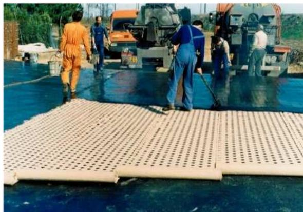
Photo n° 27 : La chape d'étanchéité en asphalte en deux couches.
