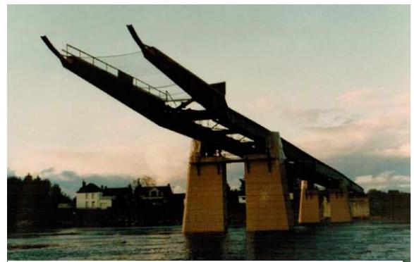
*Photo n° 25 : Lancement du tablier à partir de la RD (c'est moins spectaculaire, mais c'est le même principe que le lancement des deux rampes en béton précontraint du pont de Normandie qui décorait la carte de vœux de notre président).*
