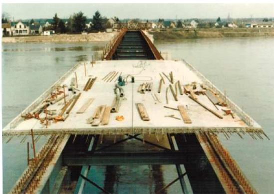
Photo n° 26 : Coulage du premier élément du tablier. On voit les connecteurs qui assurent la liaison entre la poutre métallique et le ferrailage de la dalle.
