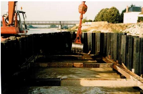
*Photo n° 24 : Batardeau de palplanches métalliques avec un niveau de tirants intérieur pour permettre le creusement du massif de fondation en béton immergé. Les palplanches sont battues avec un mouton diesel d'environ une tonne, et, là, on avait toute la hauteur nécessaire.*
