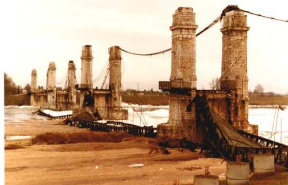
*Photo n° 14 : De la rive droite vers la rive gauche, on remarque les suspentes cassées au niveau des étriers d'attache sur les câbles de suspension ; les câbles de tête amont sont restés en place avec les chaises mobiles au-dessus du pylône (chariots retenus par les câbles de tête qui assuraient la continuité des câbles de suspension)*
