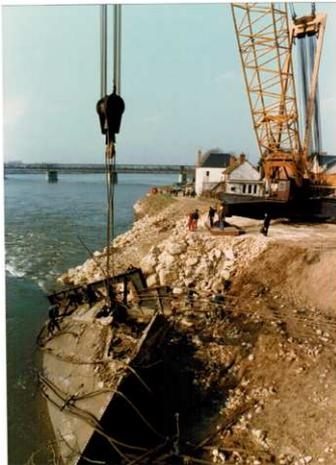
*Photo n° 22 : Dégagement du tablier de la travée RD avec une grue de 600 t qui a nécessité 8 camions en provenance d'Alsace avec une autorisation de transports exceptionnels, alors qu'il y avait des barrières de dégel.*
